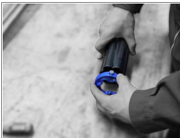
Установка уплотнительного кольца
