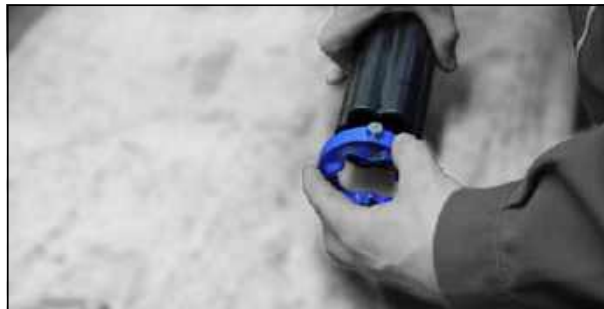
Установка уплотнительного кольца
