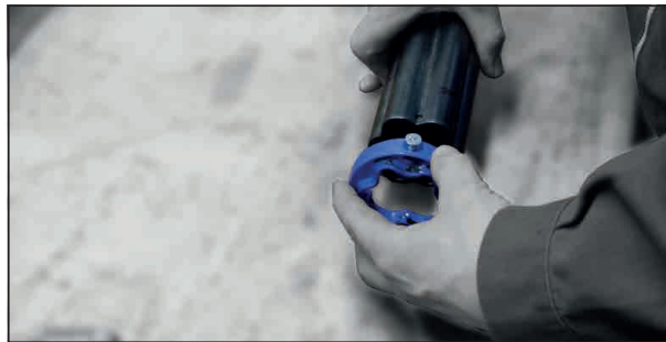
Установка уплотнительного кольца
