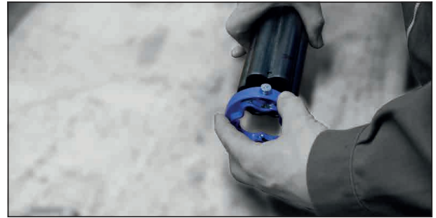
Установка уплотнительного кольца
