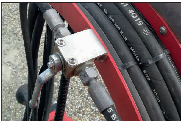
Запорный кран поддерживающего управляемого моста закрыт (парковочное положение)
