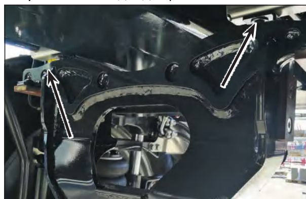
Подъемное устройство с монтажным уголком
